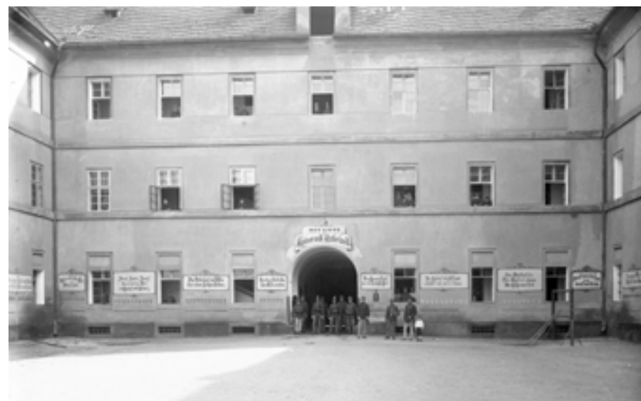
Nádvoří kasáren kolem roku 1895
