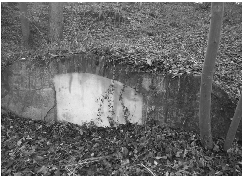
Zazděný vstup do štoly pod Všemi svatými
